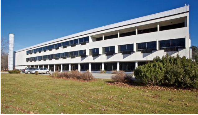
Le Collège Saint-Augustin, qui sera transformé en Complexe communautaire, culturel et sportif
